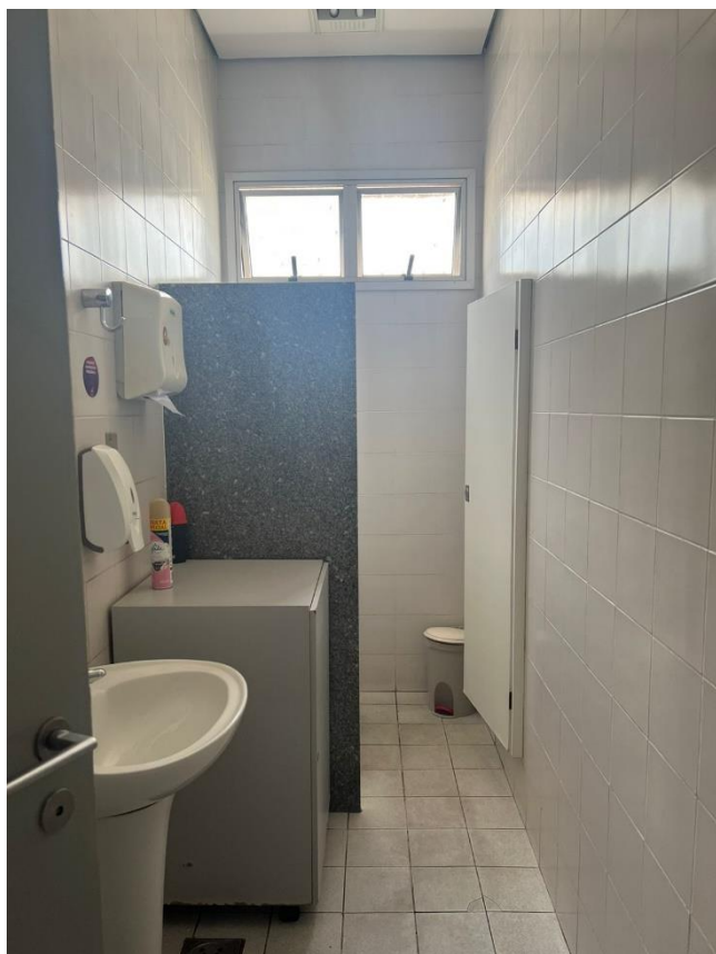
Figura 10 – Banheiro Privativo – Sala Comercial
