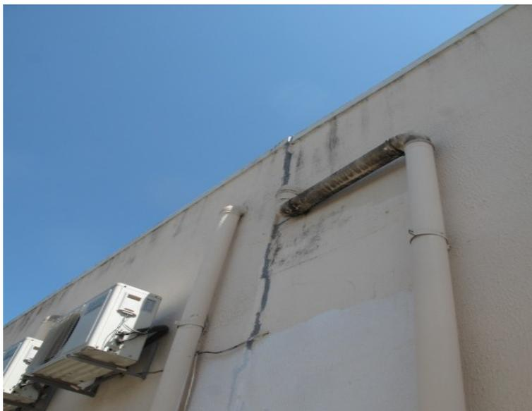
Foto 6 – Trechos de tubulações e conexões deverão ser substituídas (todas as descidas de AP)
