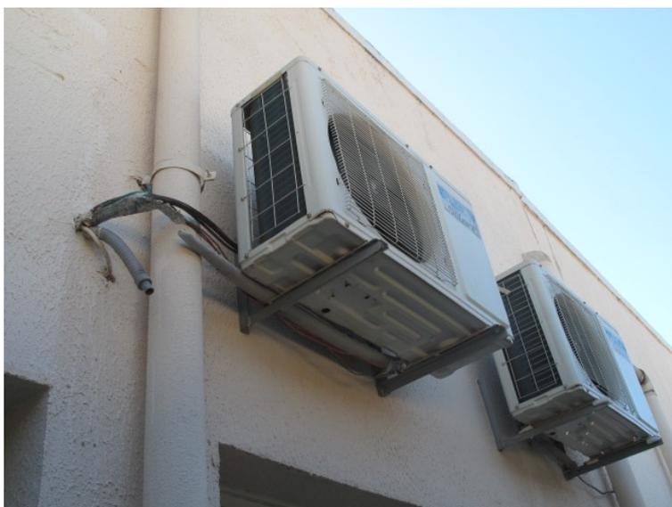
Foto 19 – Drenos de ar condicionado sem condução apropriada, mantendo os pés das paredes externas constantemente úmidos
