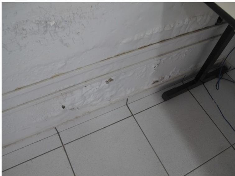
Foto 15 – Infiltração (sala da OAB)
