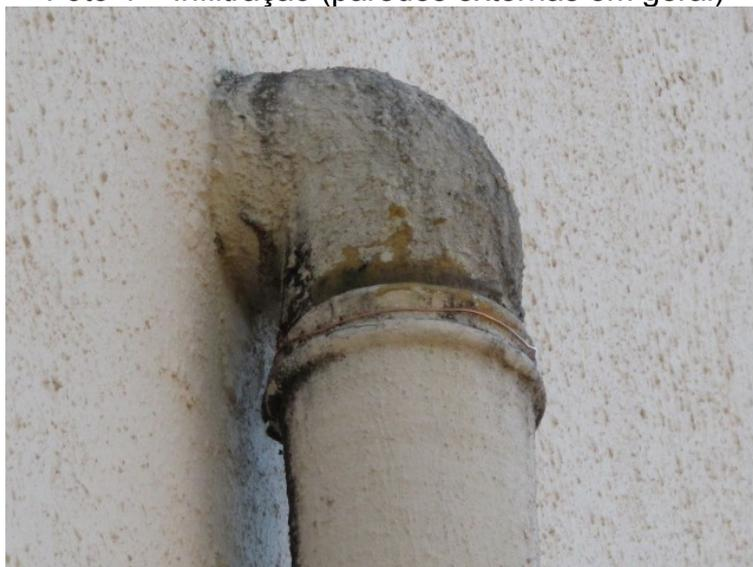
Foto 5 – Trechos de tubulações e conexões deverão ser substituídas (todas as descidas de AP)
