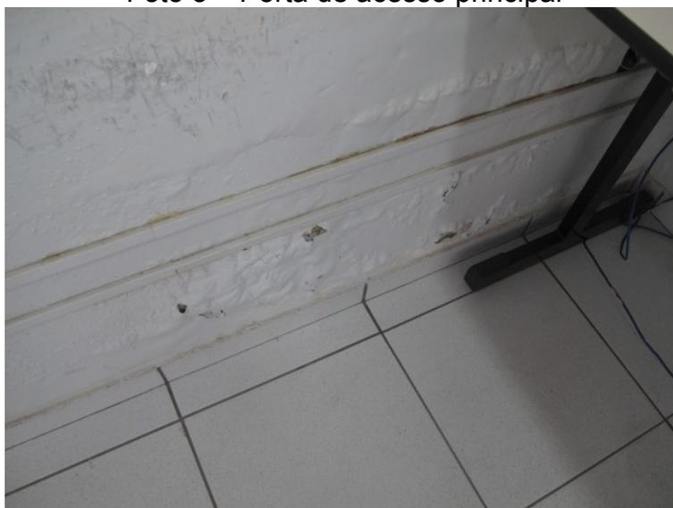
Foto 4 – Infiltração (paredes externas em geral)
