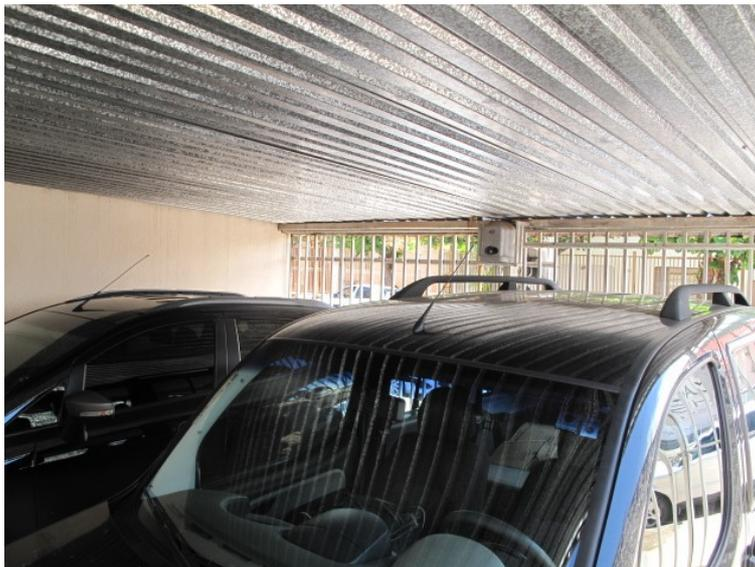
Foto 8 – Telhamento metálico da garagem sem pintura (deverá ser pintado)
