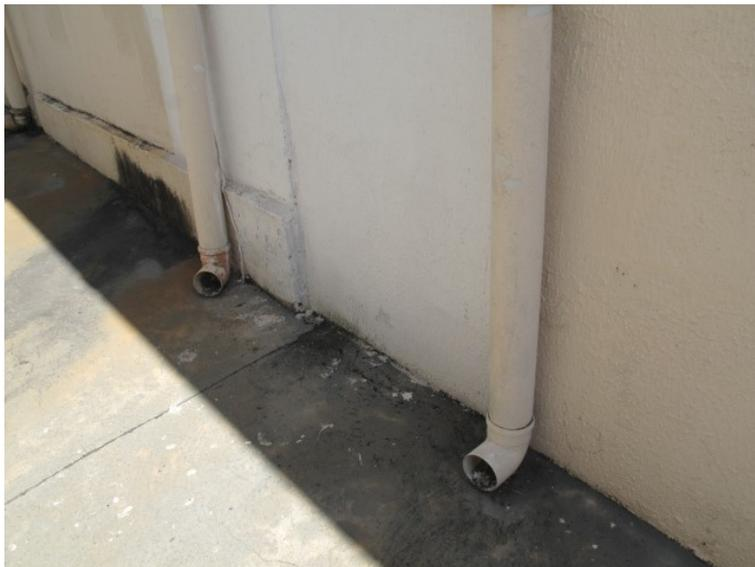
Foto 10 – Tubulações de descida sem adequado direcionamento
