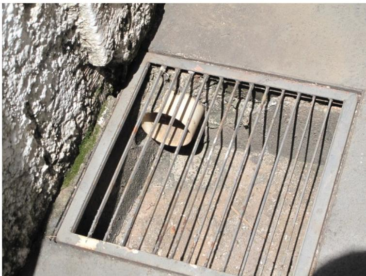
Foto 9 – Caixa de AP existente, as tubulações de descida deverão ser embutidas no contrapiso e direcionadas as caixas existentes ou às novas criadas
