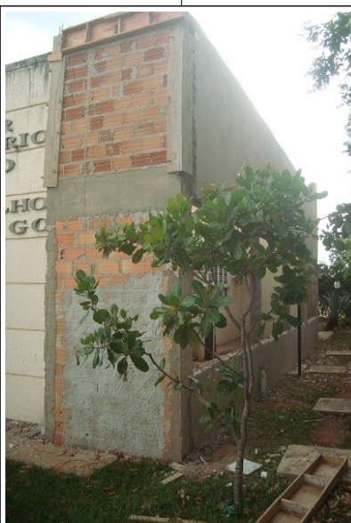
Vista ampliação lado direito
