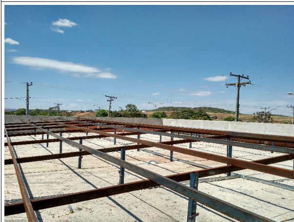
Vista cobertura iniciada
