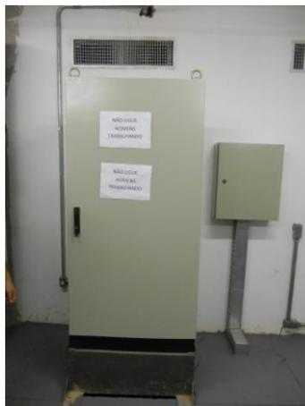
Uma questão importante a ser urgentemente resolvida é a identificação das portas por onde estão instalados circuitos de alta/média tensão. Esses representam riscos reais de morte e devem ser identificados conforme a ABNT.
