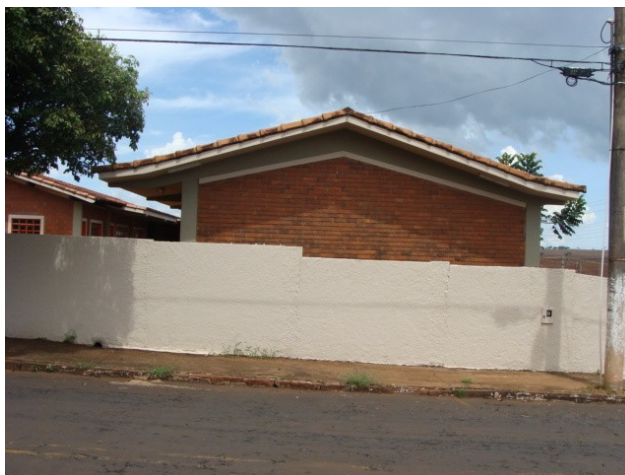
Vista da Calçada
