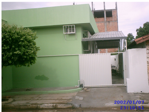
Portão de acesso de veículos
