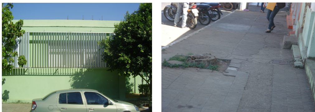
Obstáculos na calçada
