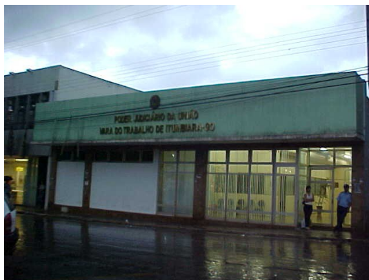
Vista da Calçada
